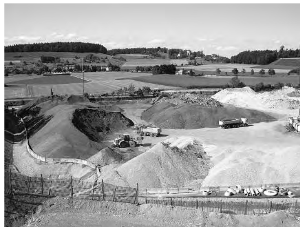
Installationsplatz Dreivierlig (Etape 7)
