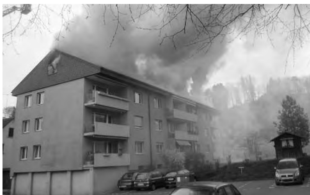
Dachstockbrand Mehrfamilienhaus in Sennhof vom 10.4.10 mit Grossaufgebot von über 100 Feuerwehrleuten
