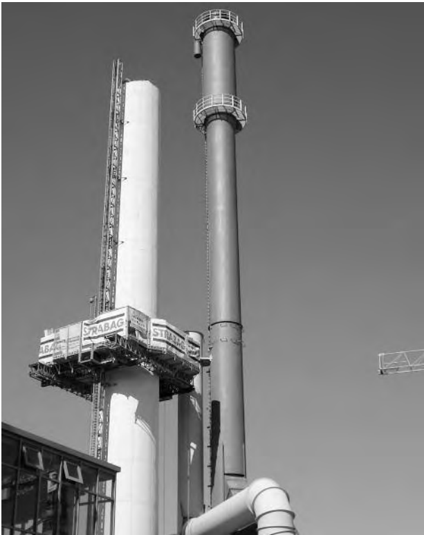
Das bisherige Wahrzeichen der Grüze, der 80m-Betonkamin der KVA, verschwindet im Zuge der Erneuerungsarbeiten.
